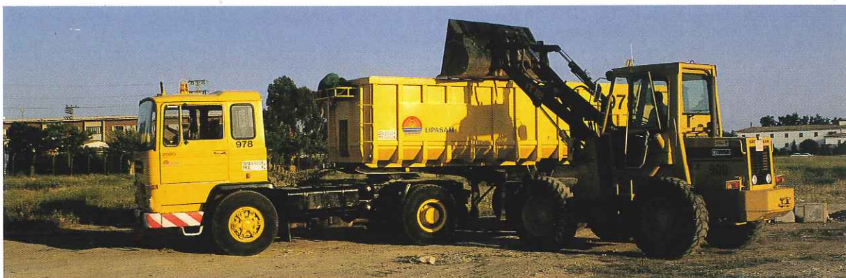
Limpieza de solares y escombros.
