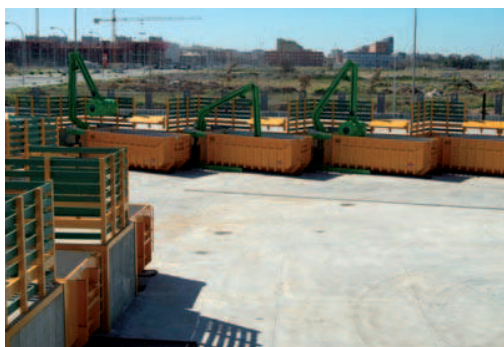
Zona de contenedores en un Punto Limpio
