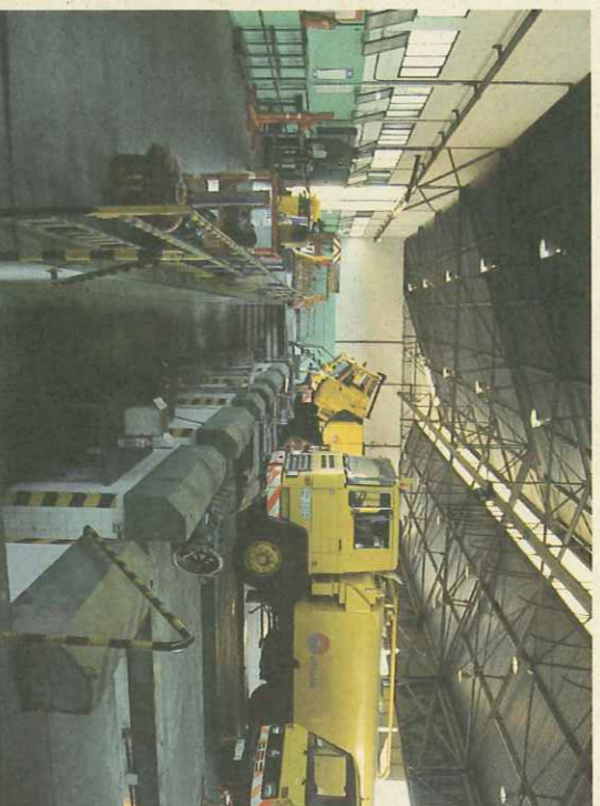
Una vista general del taller, después de las obras de remodelación.
