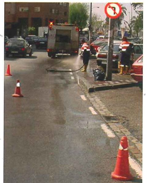
Los conos se situarán en diagonal, tras el vehículo, como muestra la fotografía.
