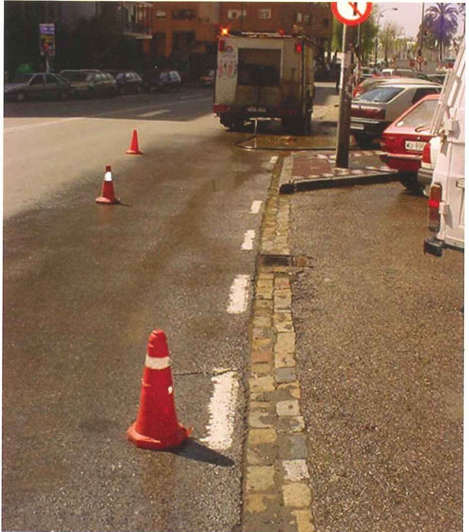
Los conos se situarán en diagonal, tras el vehículo, como muestra la fotografía.
